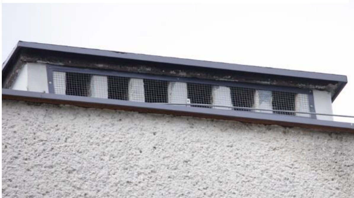
Fotografia 2. Okratowanie otworów kominowych w badanym budynku, uniemożliwiające wejście ptakom, które mogą budować gniazda w takich miejscach, np. kawkom
